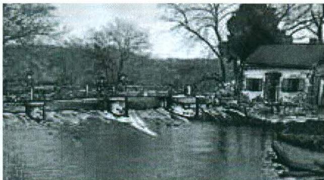
Évocation des barrage, écluse et maison éclusière de Comblain-Fairon
