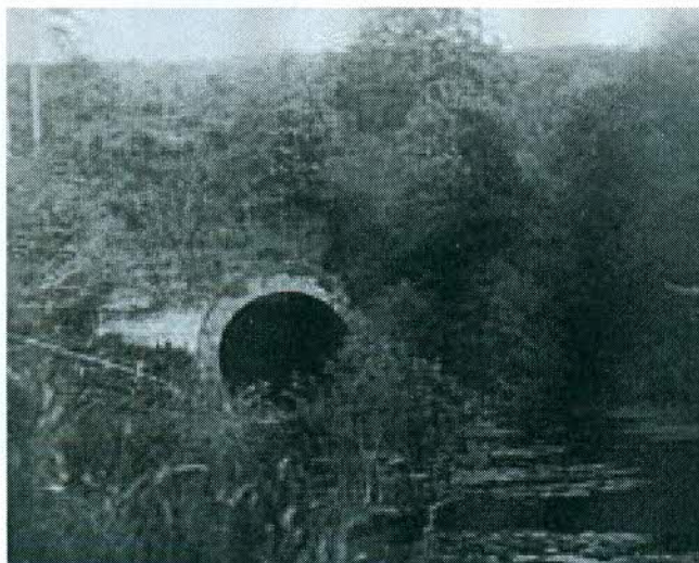
Entrée du souterrain de Buret avant 1960
